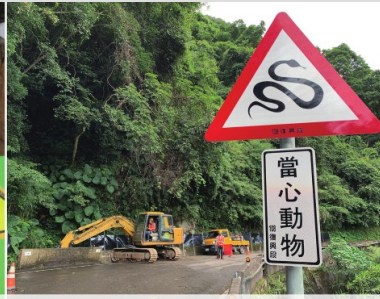
省道台7線北橫公路上保育類蛇類路殺警示標誌及防護導引圍籬
